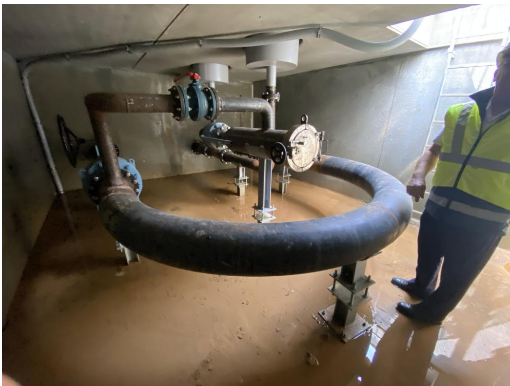
Chambre à vannes DEA Istres (3m x 3,13m x 2m)
