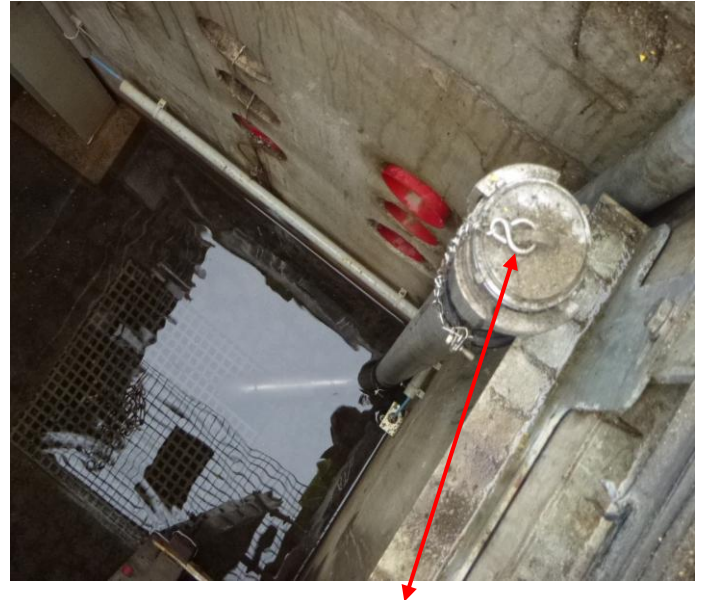
Chambre à vannes (3m x 3m x 2,60m) possédant tuyauterie avec raccord \frac{1}{2} symétrique pour permettre le pompage de l'eau au DEA Orléans
